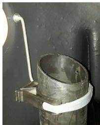
Danach die beiliegende Rohrschelle montieren, wobei die Gewindestange so weit wie möglich über den Ablauf hinausstehen sollte.
