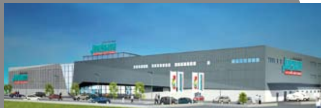
GEOCELL: Lastabtragende Wärmedämmung für modernes Einrichtungshaus
