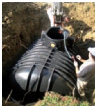
Einsetzen des Kunststofftanks bei der Familie Stritzinger
